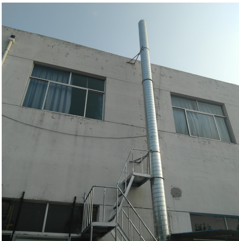
图 3-2 吹塑车间排气筒
