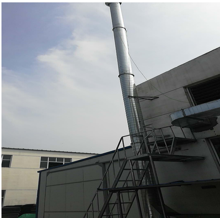
图 3-1 注塑车间排气筒
